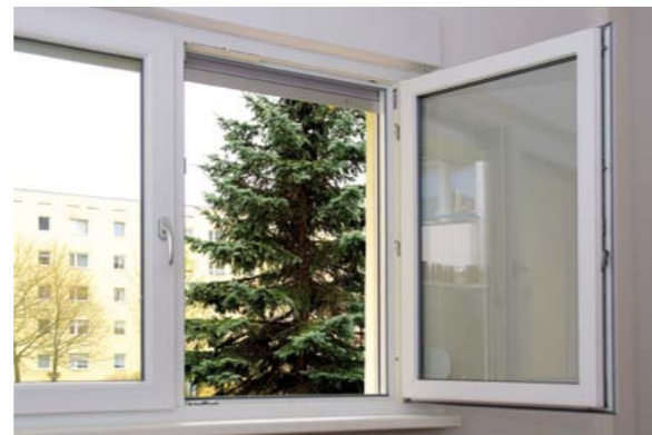
In allen Georgenthaler Wohnungen wurden im vergangenen Jahr neue Fenster eingebaut.
