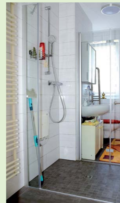
In Erdgeschosswohnungen werden ebenerdige Duschen eingebaut.
