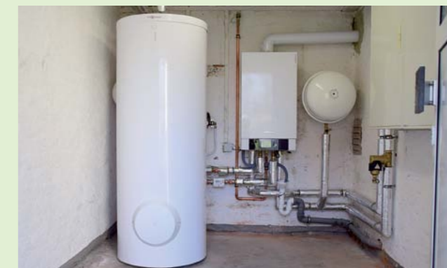
In zwei Wohnhäusern wurde im April des Jahres die Heizungsanlage mit einer Leistung von 26 KW erneuert.
