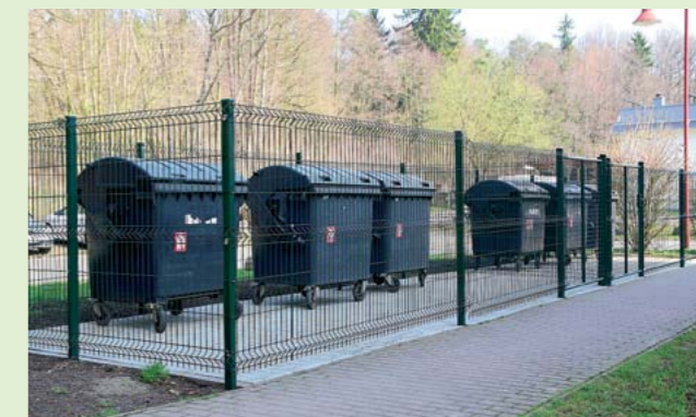
In Georgenthal entstand im Dezember 2017 ein neuer umfriedeter Müllplatz für zwei Wohnhäuser.
